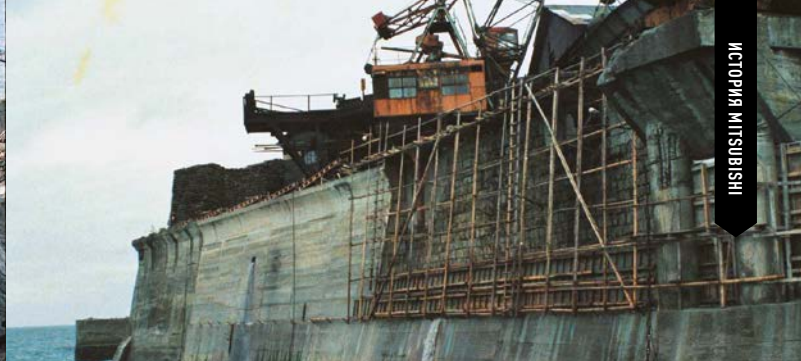
Морская дамба, включенная в список всемирного наследия. Сейчас она ремонтируется, поэтому видна каменная кладка с красной глиной и известью, которые служат связующими материалами (так называемый метод Амакава).
